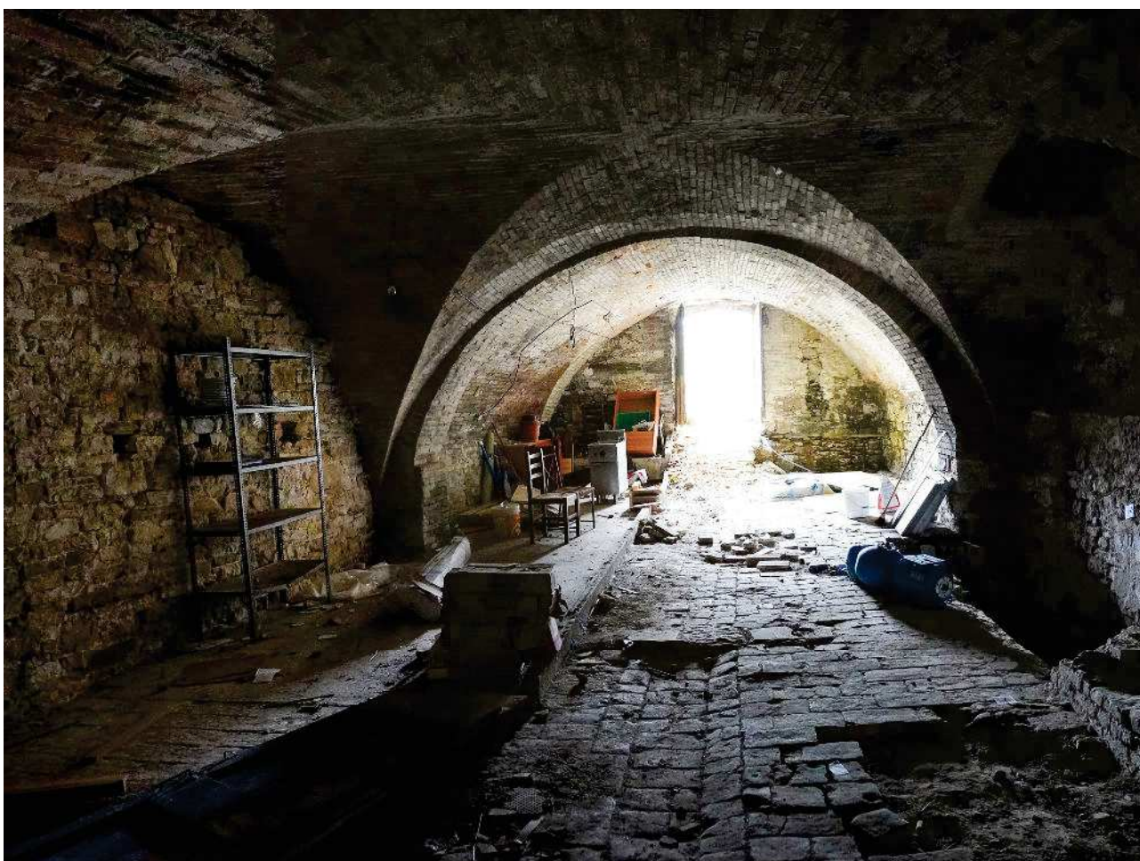
Foto 15 Piano interrato. Vista della cantina dalla parte della nevieria.
