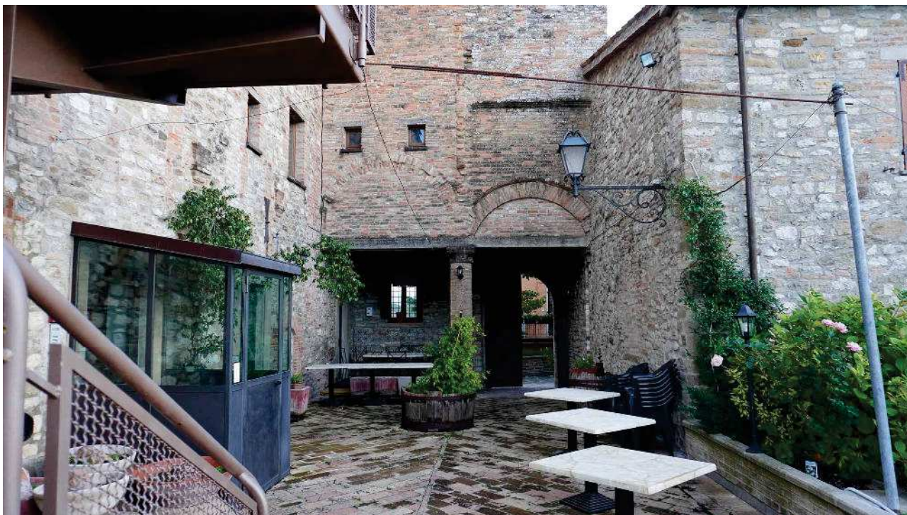
Foto 14 Corte interna di Palazzo Vandini vista dalla scala esterna di sicurezza.
